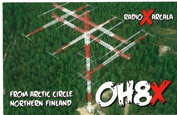
Figura 24 - Essa é a famosa Yagi de 3 elementos para 80m da Radio Arcala!! Trata-se de um grupo de radioamadores finlandeses que construíram esse arranjo: 3 elem. 80m + 4 el 40m + 2x 4 el. 20m. A torre inteira é giratória e o motor na base é gigantesco. A torre tem 90m de altura total – 35 andares – observe a altura da floresta de pinheiros abaixo da torre, aquilo não é mato!.
